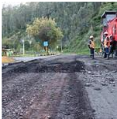
Ilustración 4. Imprimación asfáltica ETN
