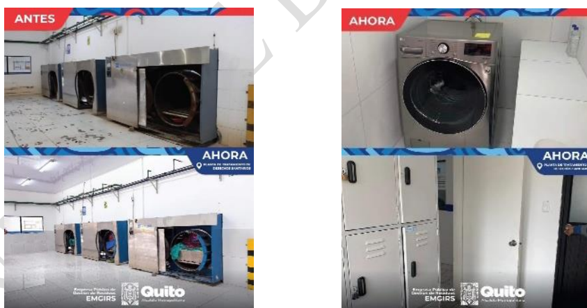
Ilustración 17. Mejoramiento y mantenimiento de la PTDS
