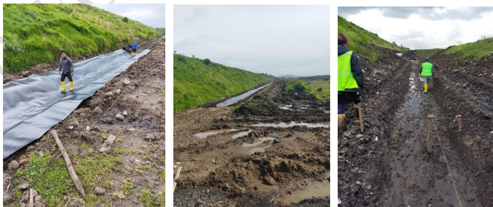
Ilustración 20. Construcción del sistema de drenaje – Escombrera Troje 4 Fase 2
