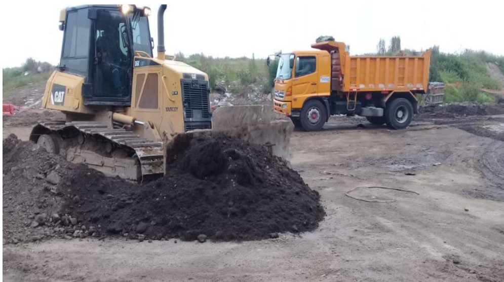
Figura 19: Operación de escombreras
