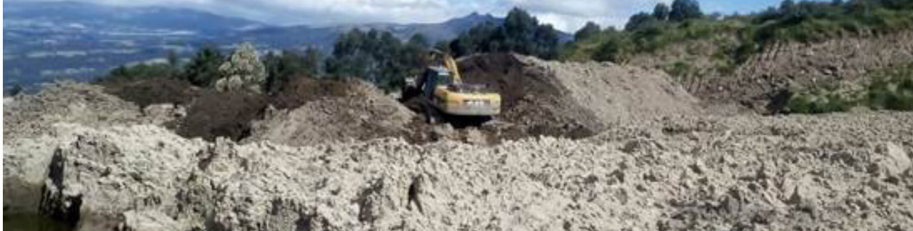
Escombreras. Construcción de Cubeto de lodos
