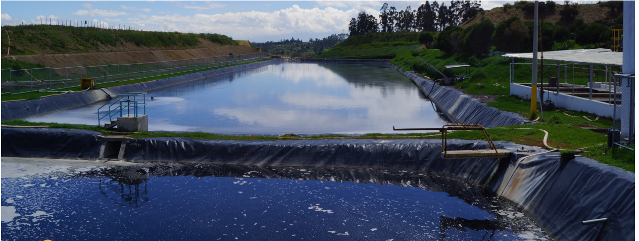
Tratamiento. Piscinas de Almacenamiento de Lixiviados
