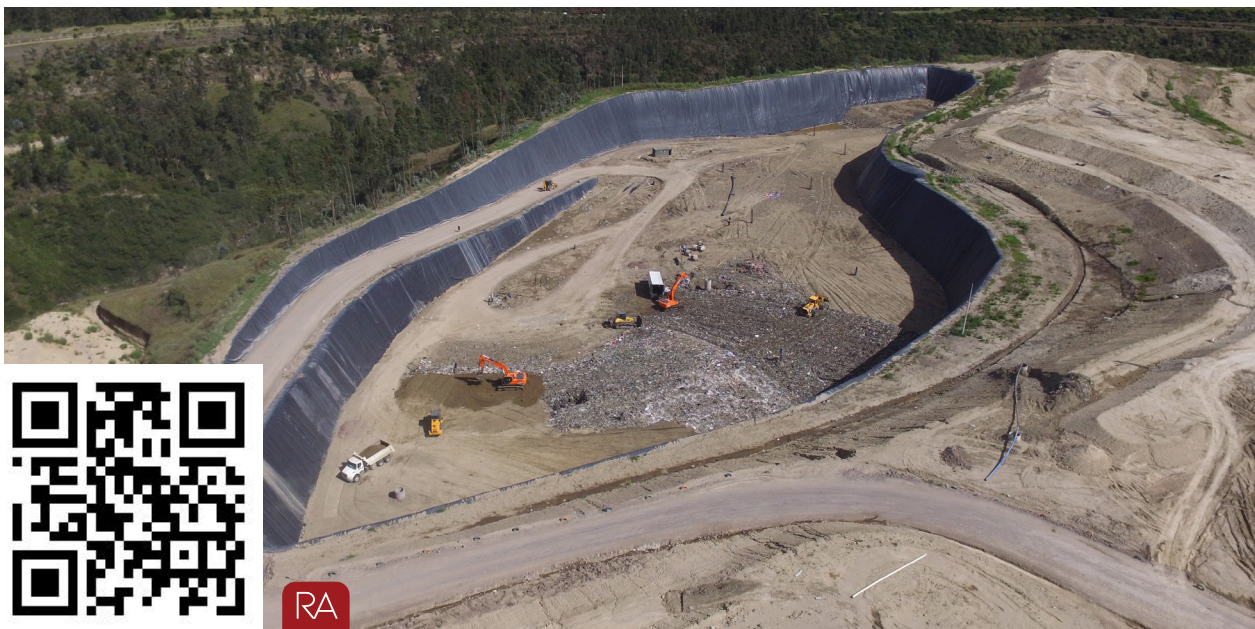
Relleno. Disposición Final - Cubeto 9A
