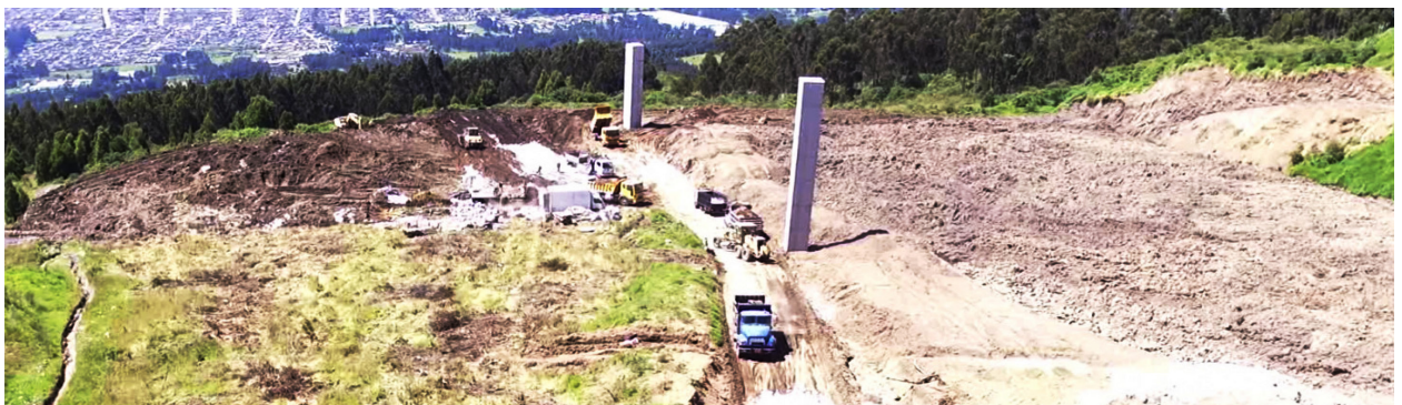
Escombreras. Colector Troje 4
